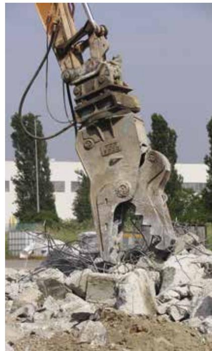
◀ CO-PROTAGONISTA IN CANTIERE È STATO IL FRANTUMATORE GIREVOLE FP20, QUI UTILIZZATO PREVALENTEMENTE PER ESEGUIRE GLI INTERVENTI DI DEMOLIZIONE SECONDARIA
