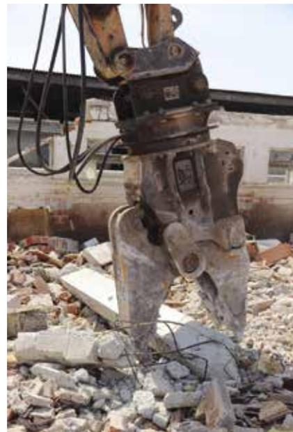
➤ **PROTAGONISTA ASSOLUTO IN CANTIERE È STATO IL MULTIPROCESSOR CK21: COSTITUITA DA UN CORPO TELAIO PORTANTE AL QUALE POSSONO ESSERE AGGANCIATE IN POCHI MINUTI DIVERSI KIT DI CHELE, QUEST'ATTREZZATURA SI È DIMOSTRATA ESTREMAMENTE VERSATILE ANCHE NEGLI INTERVENTI DI DEMOLIZIONE SECONDARIA**
