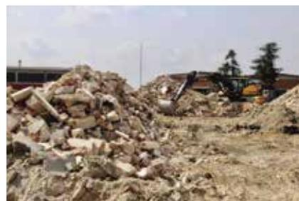
◀ L'INTERVENTO NEL CANTIERE DI GUASTALLA HA PREVISTO LO SMONTAGGIO DI STRUTTURE PREFABBRICATE, CON IL RECUPERO DEL MATERIALE FERROSO DERIVANTE DALLA DEMOLIZIONE DELLA TETTOIA, E UNA SERIE DI INTERVENTI DI DEMOLIZIONE GENERALE
