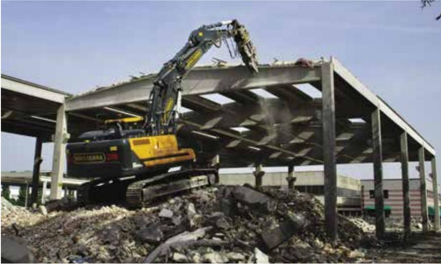
*che hanno costituito la demolizione delle fondazioni, dei plinti e dei basamenti dei macchinari qui trovati, attività che ha incluso i relativi scavi, demolizioni, smaltimento ai centri di riciclaggio e reinterro con materiale di risulta. Prodotto che per il 90% è stato recuperato e riutilizzato come materia prima”.*
